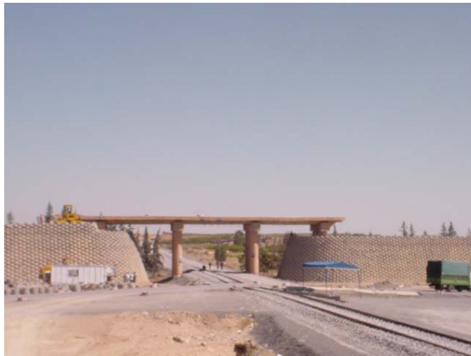
Photo 11 : vue de l'ouvrage en construction
