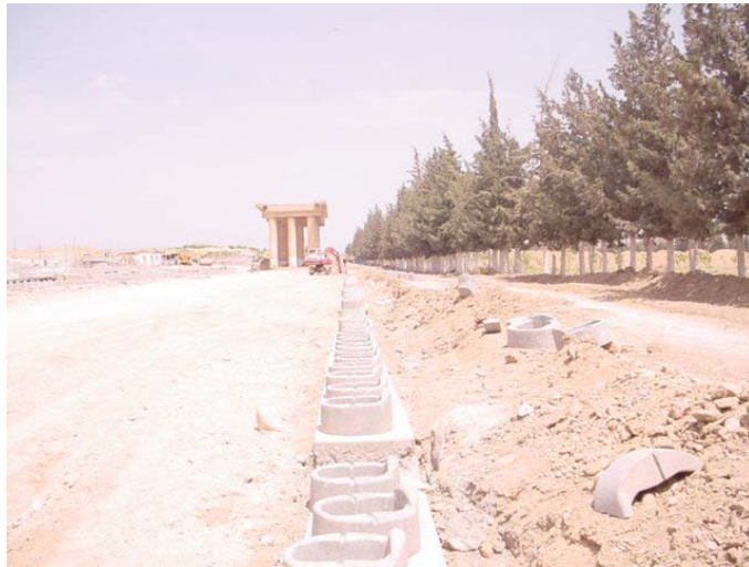
Photo 7 : mise en œuvre du béton de propreté et matérialisation des redans
