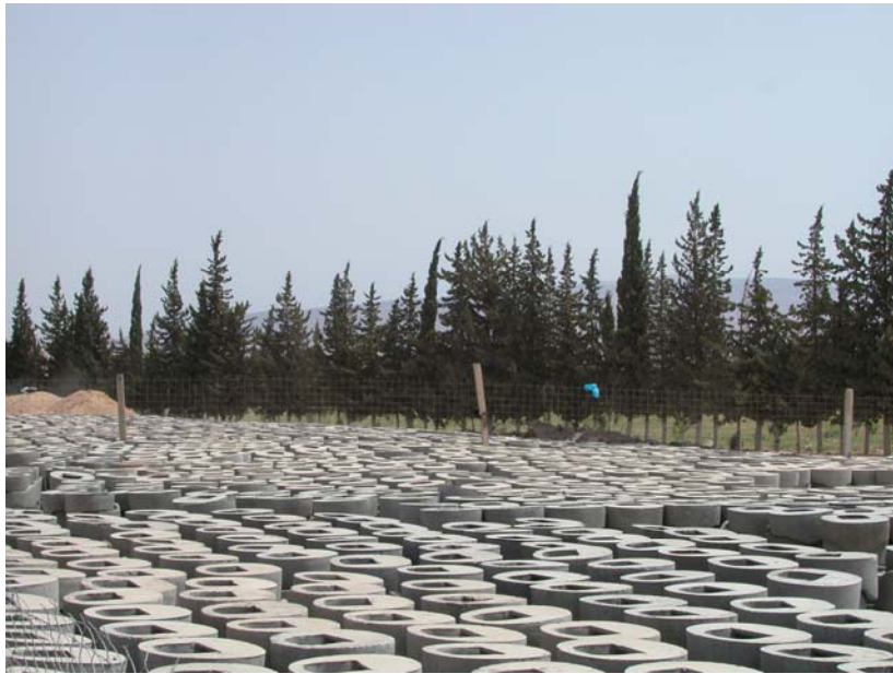
Photo 5 : zone de stockage des éléments cellulaire du parement sur site
