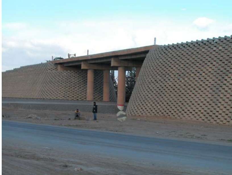
Photo 13 : vue de l'ouvrage achevé
