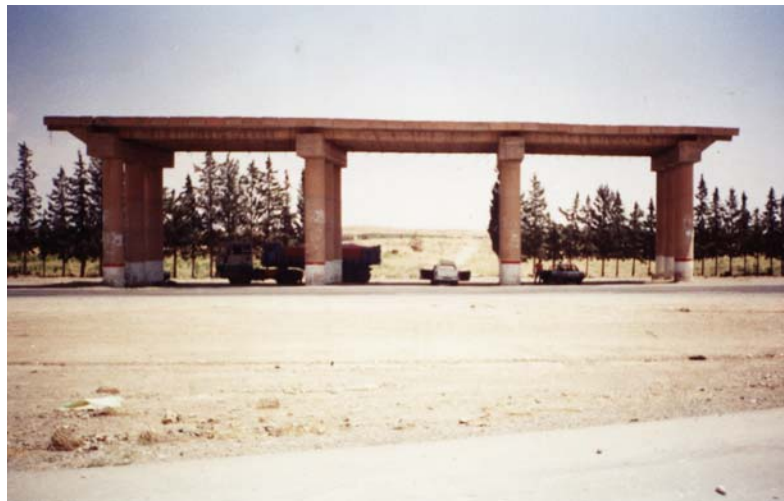
Photo 1 : vue de l'ouvrage
