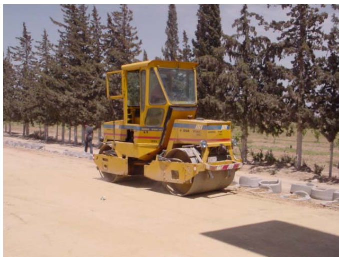
Photo 9 : compactage des couches de remblai
