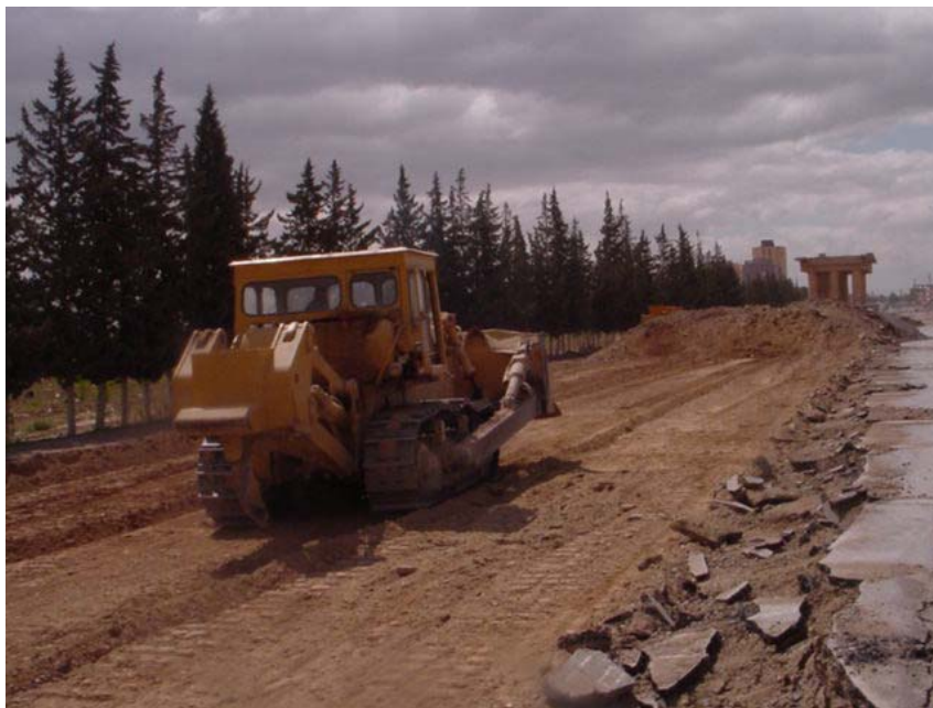
Photo 6 : décapage de 70 cm sur toute la surface du projet
