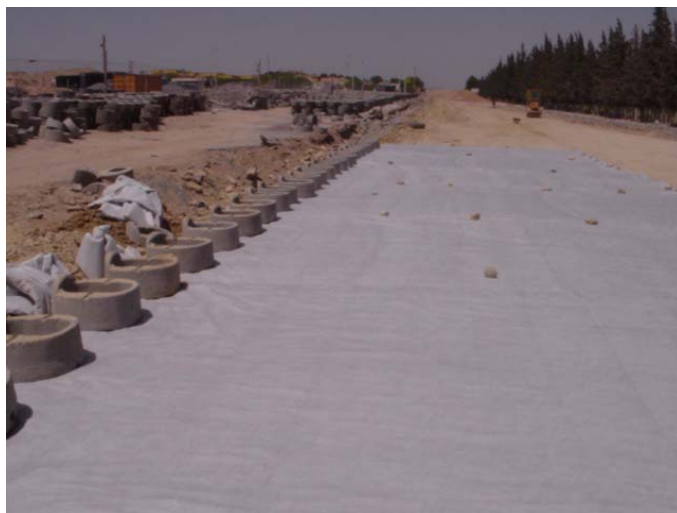
Photo 8 : pose des éléments de parement et des nappes géotextile de renforcement
