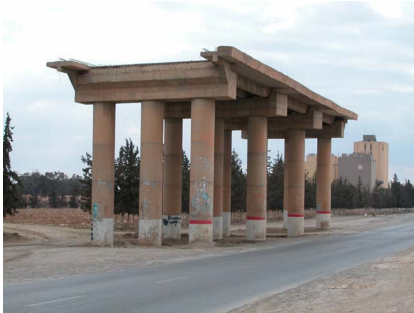
Photo 2 : vue de l'ouvrage, de l'exploitation agricole et des habitations
