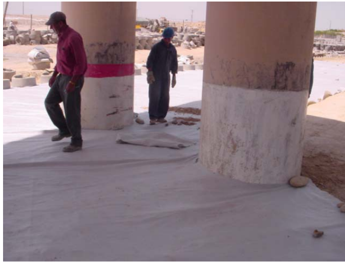
Photo 10 : détail de pose des géotextiles au droit des piles
