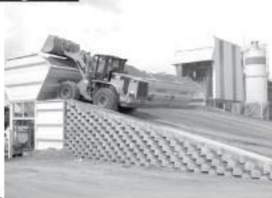
La largeur du remblai est au minimum de 50 cm derrière les pierres
