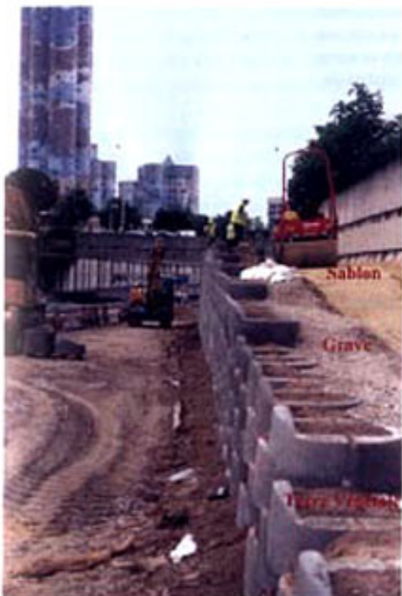
Photo 3 Ouvrage en construction. Détails Structure undergoing construction, Detail views
