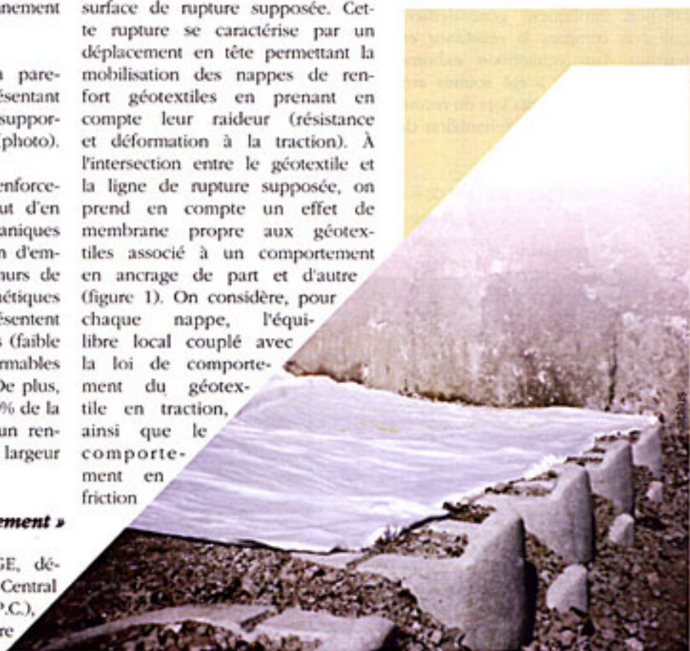
Photo : couche renforcée à parement en éléments béton
